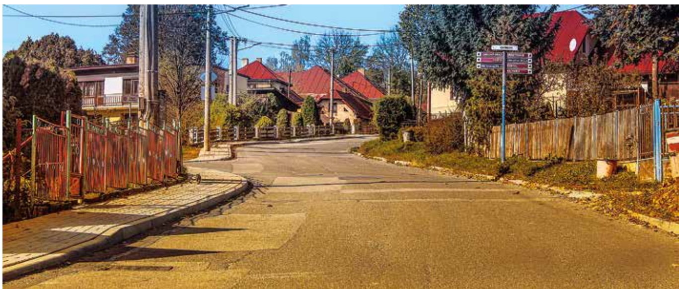
Na Ulici Jána Vojtaššáka sme zrekonštruovali existujúci chodník
