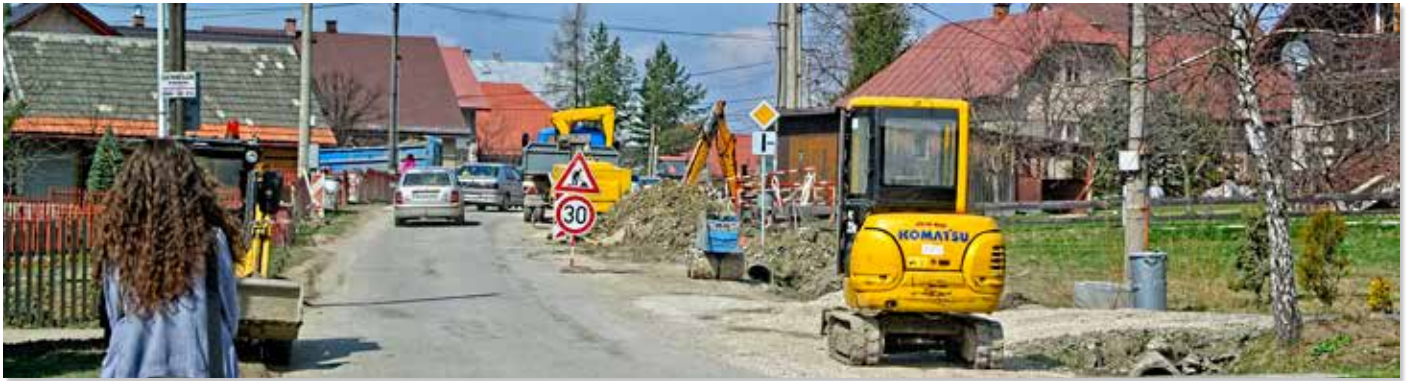
Výstavba kanalizácie v obci
