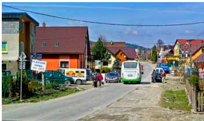
Výstavba kanalizácie v obci
