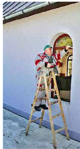
Výmena okien na dome smútku
