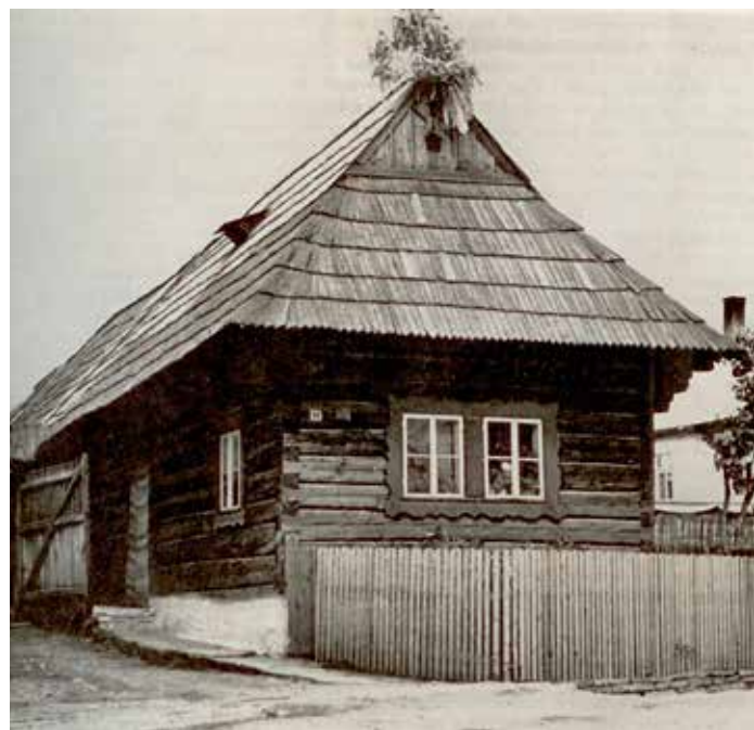
Máj postavený na štíte domu.
