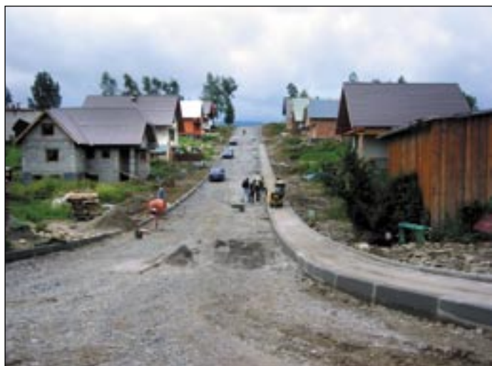
Výstavba obce v lokalite ŠPRÁL – príprava novej miestnej komunikácie a chodníka pre nové rodinné domy E-FOTO M. Iglár
