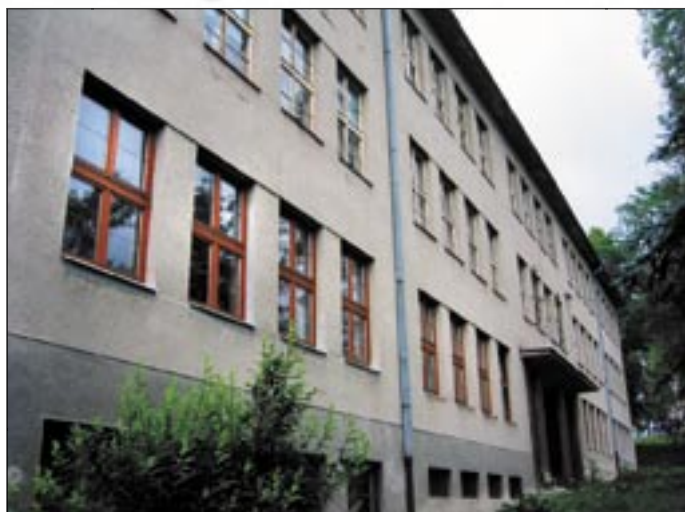
Na budove ZŠ začala výmena starých okien za EURO okná
