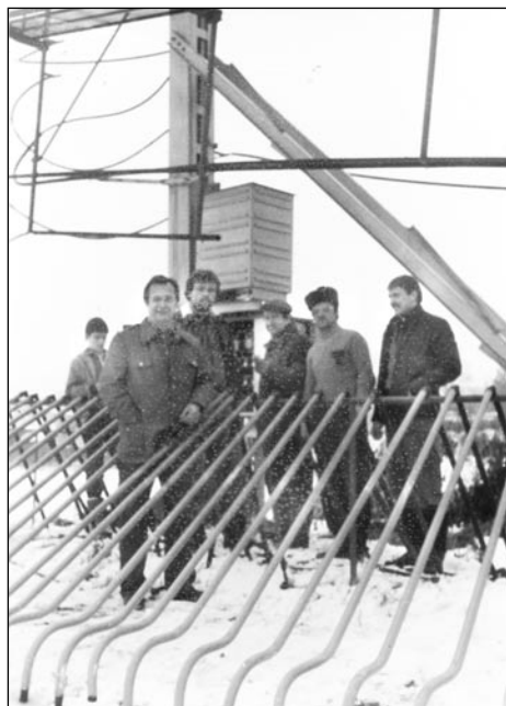
Výstavba ďalšieho lyžiarskeho vleku TATRA POMA na Kýčere
