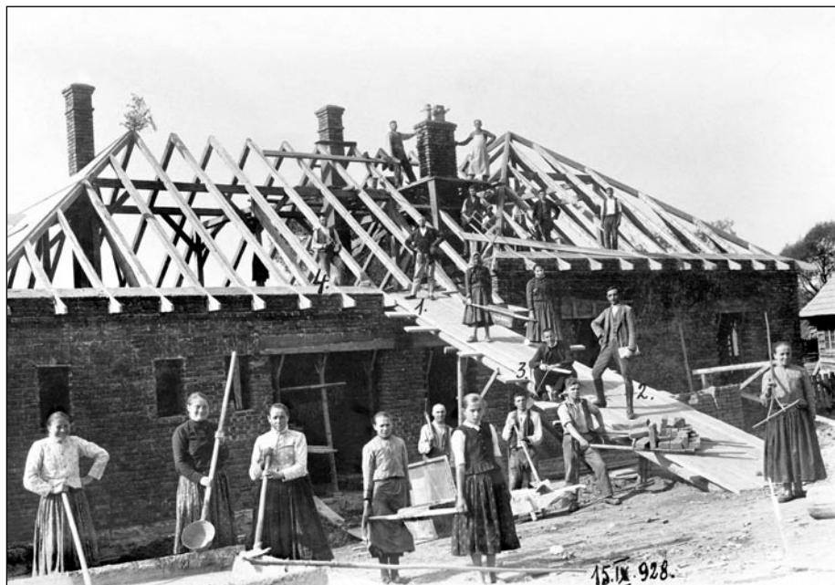
15. 9. 1928 Výstavba murovanej školy – vdp. Ján Pienčák (číslo 3)
