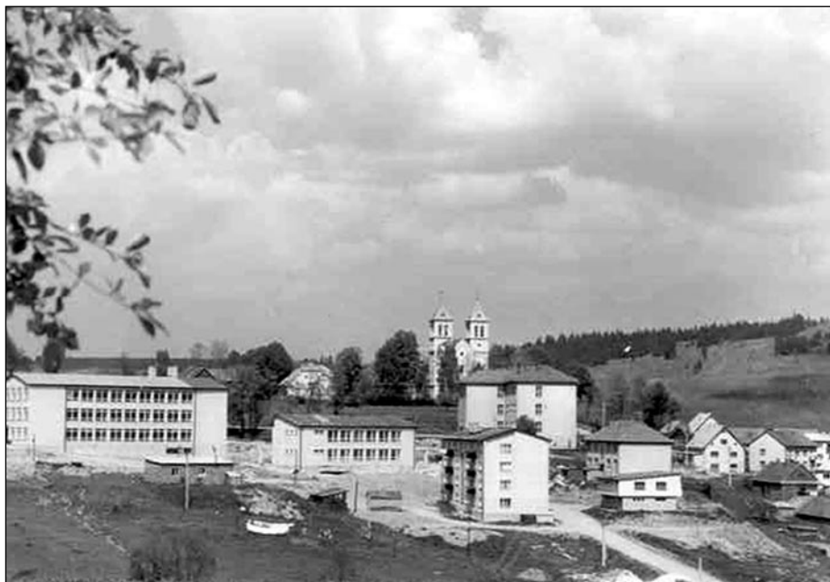
Výstavba v centre obce
