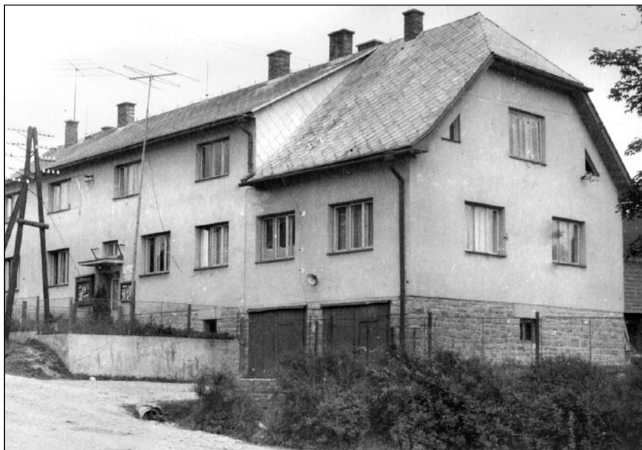
Nová budova Lesného závodu
