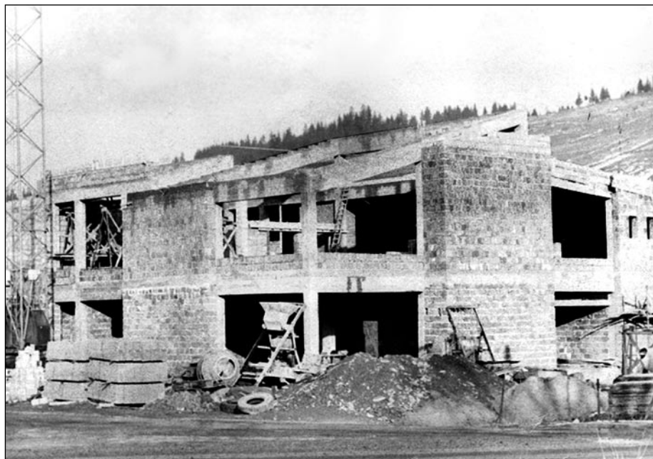
Výstavba veľkého obchodu – dnešný supermarket
